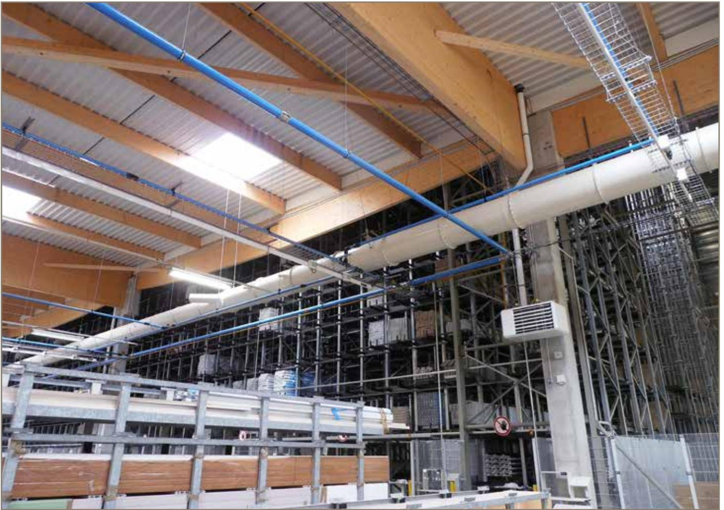
Transair®-Rohre von 25 mm (1") bis 100 mm (4") Durchmesser
