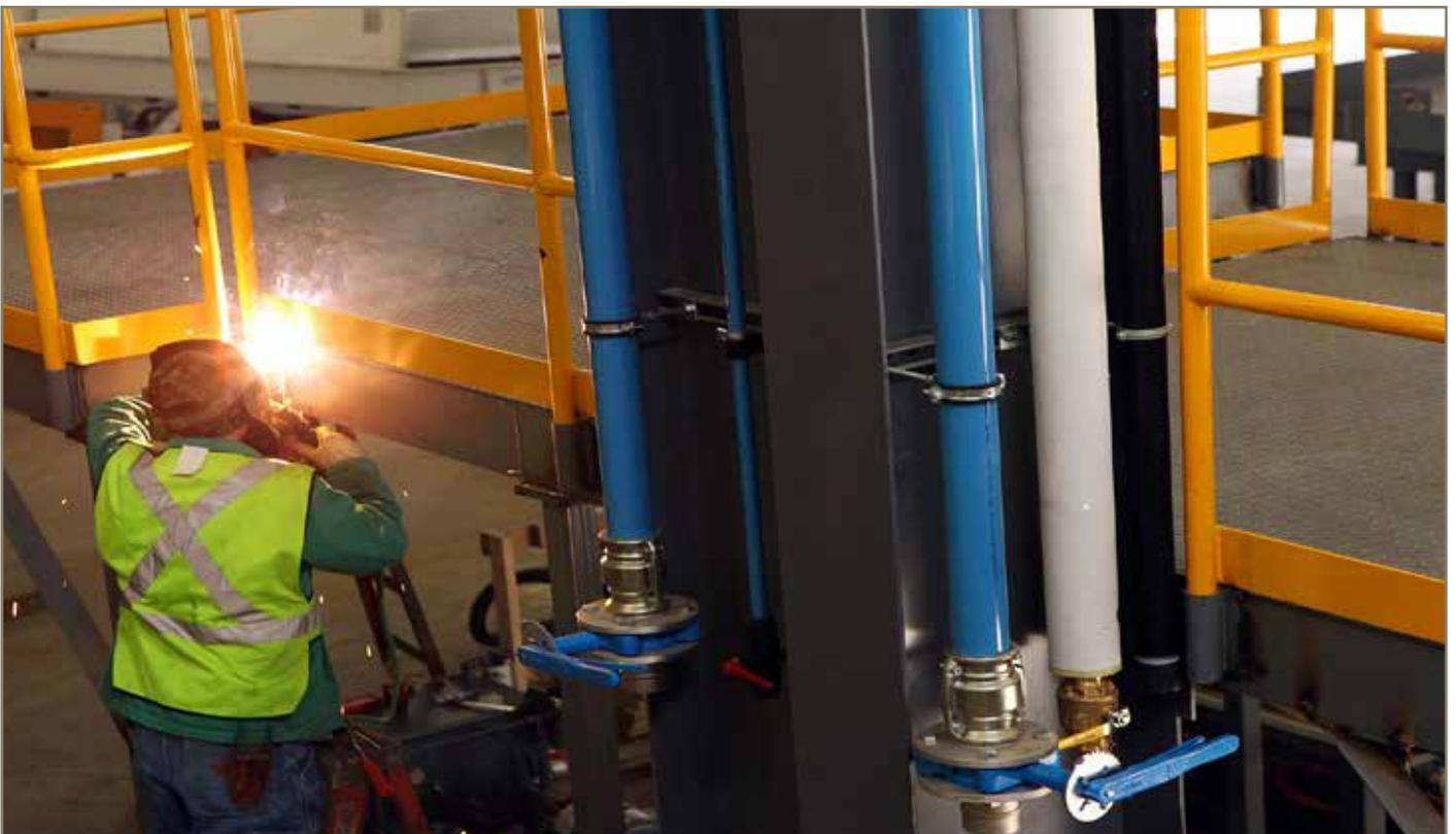
Transair®-Rohre Durchmesser 76 mm (3")
