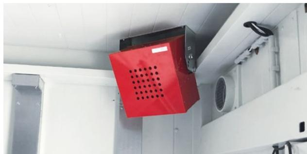
Le système d'extinction par aérosol est déclenché par la température et interrompt efficacement le processus de combustion chimique en 4,5 à 15 secondes (selon le modèle)
