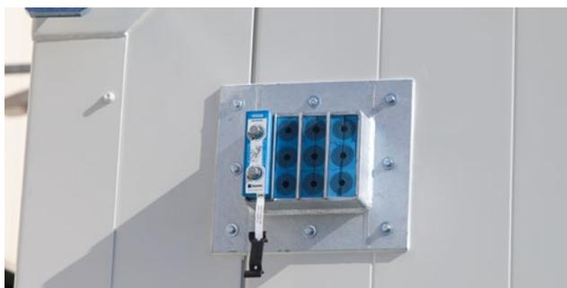
Boîte à câbles (cloison coupe-feu) pour le passage des câbles à travers la paroi de stockage coupe-feu tout en maintenant la résistance au feu de l'élément
