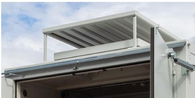
En cas d'explosion, la pression est évacuée par la surface du toit. La protection contre les intempéries permet d'éviter toute dégradation due aux charges de neige
